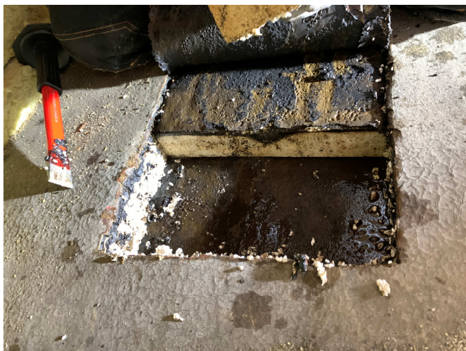
Tepelnoizolačná vrstva na báze EPS hr. 60 mm
