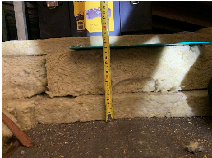
Tepelnoizolačná vrstva na báze vláknitej izolácie hr. 160 mm
